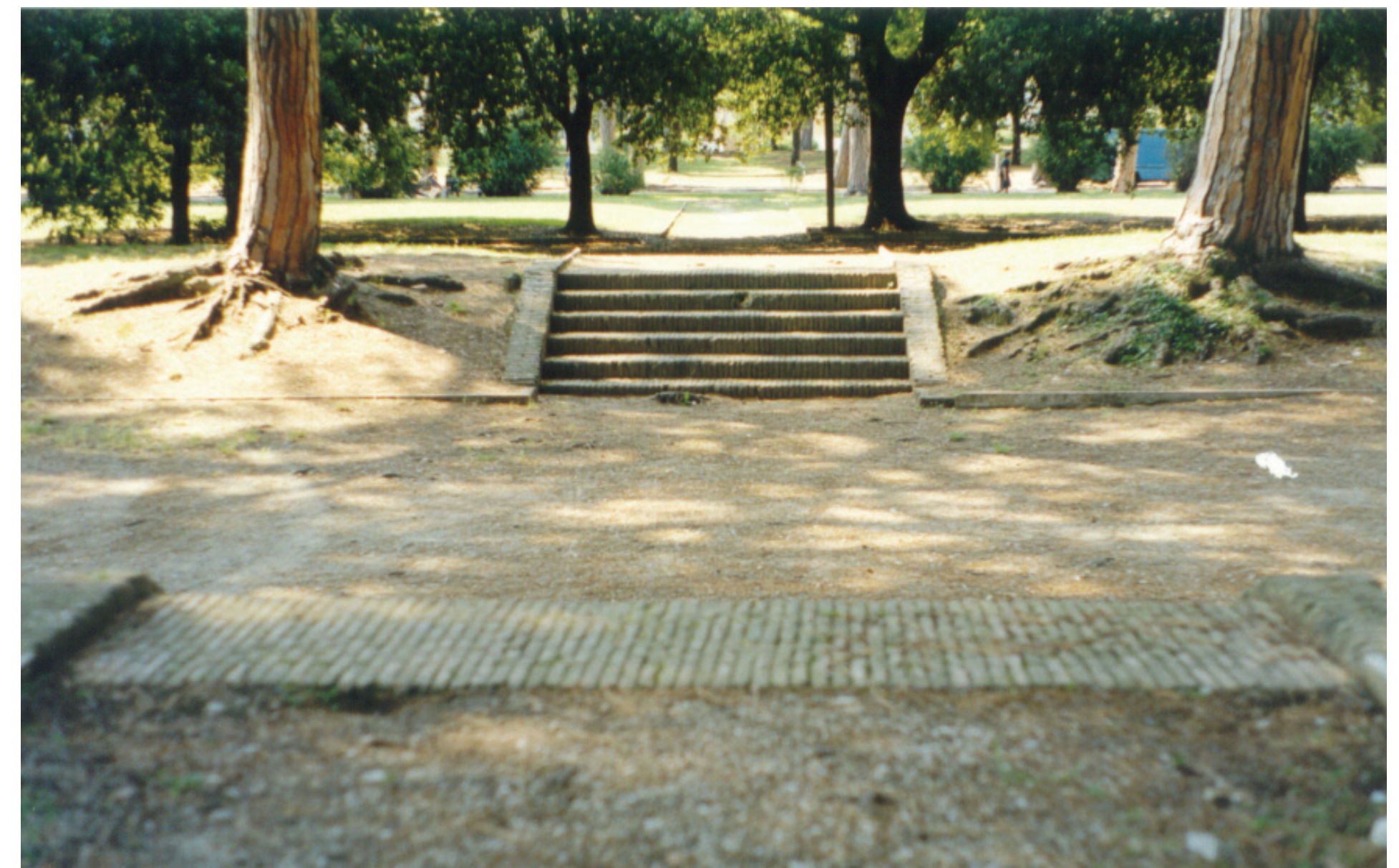
Foto 8.4 Situazioni di degrado
